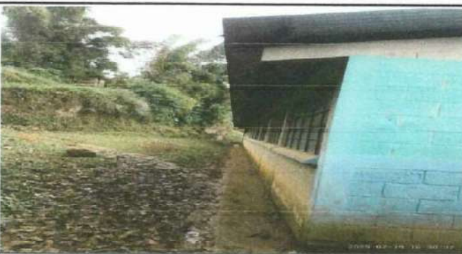
foto 5: instalación de canal y tubo de agua pluvial.
