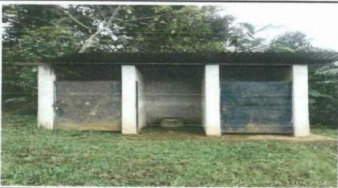
foto 3: sustitución de baños, sanitario, lavamanos, puertas, lamina.
