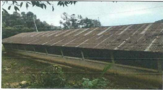
foto 1: sustitucion de láminas, por láminas troquelada y sustitución de vidrios .
