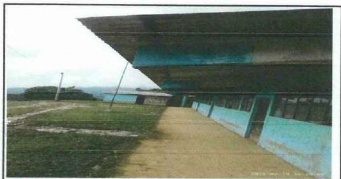
foto 6: reparación de sistema eléctrico.
